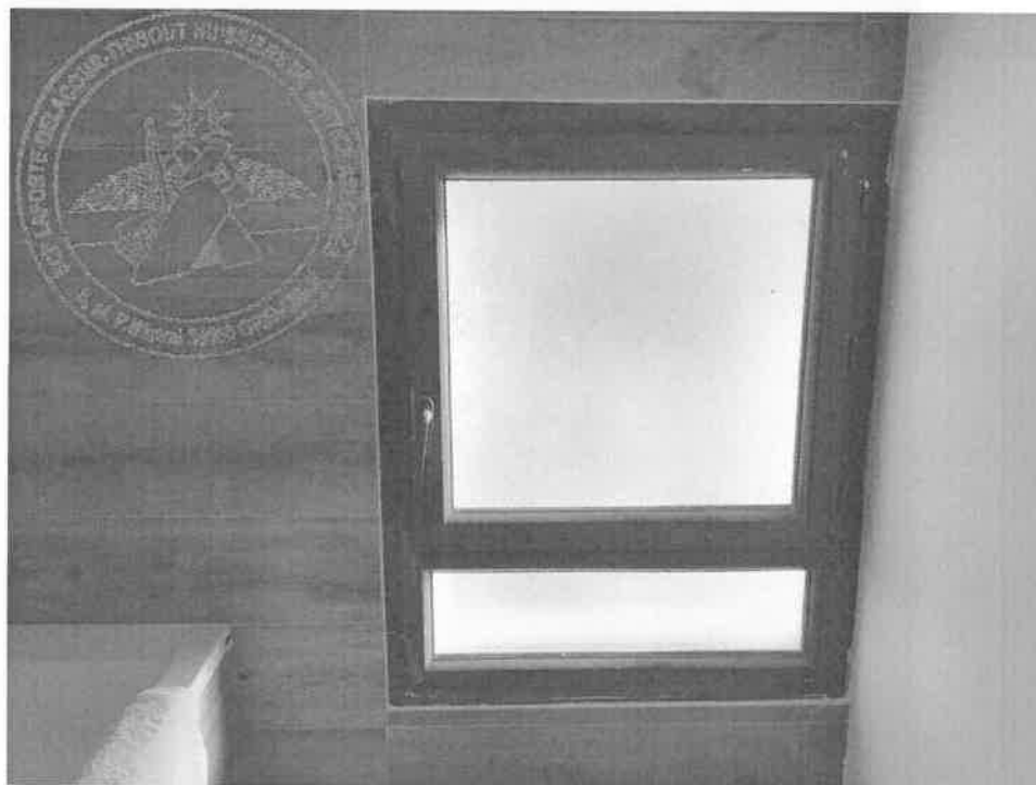
L'encadrement en bois de la fenêtre de la salle de bain présente de nombreuses traces de peinture.
