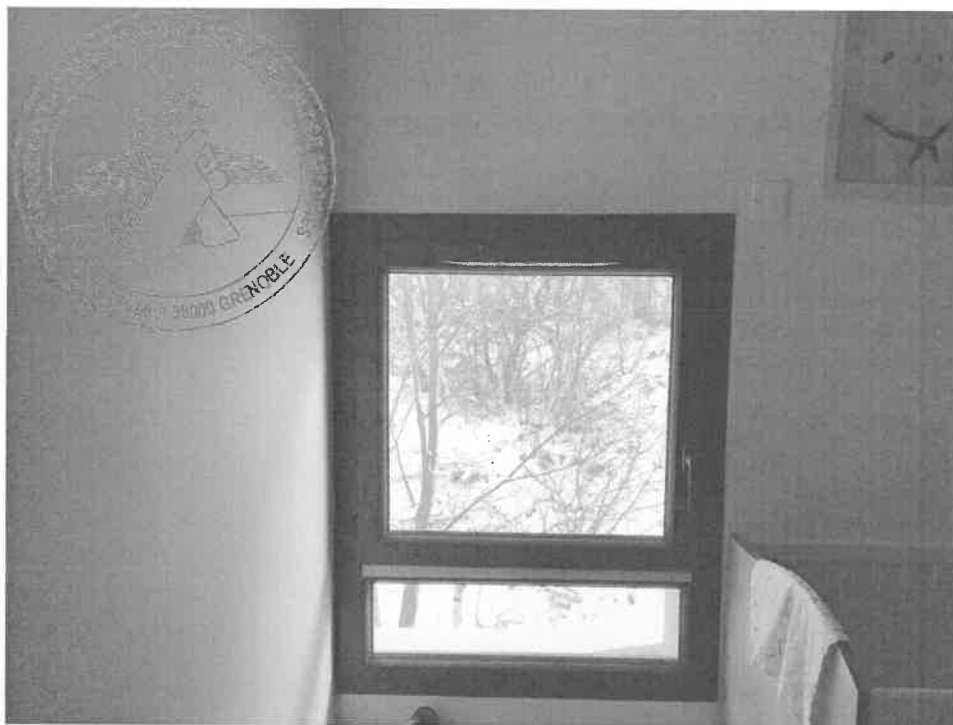
L'encadrement en bois de la fenêtre de la salle de bain présente de nombreuses traces de peinture.
